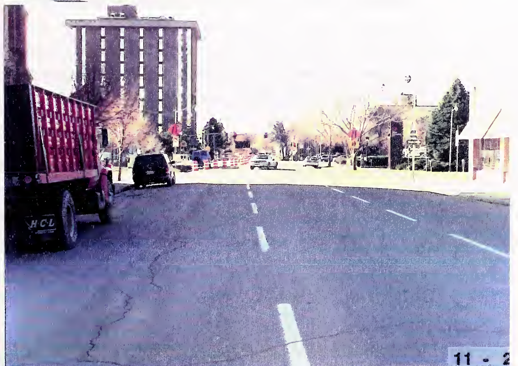
THIRD AVE. N. LOOKING WEST
